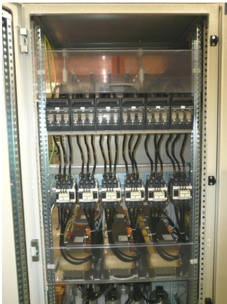
Příklad použití zákrytů pro IP XXA proti nahodilému doteku.
