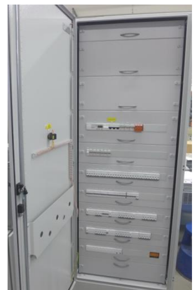
Příklad použití zákrytů RAL 7035 pro krytí IP 30 pro laickou obsluhu.
